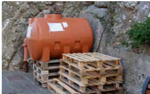
Cisterne con acqua non potabile
