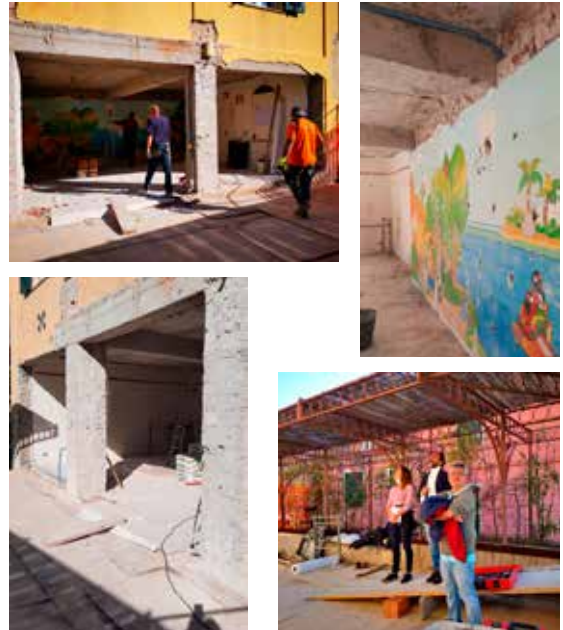
Novembre 2021: inizio dei lavori di messa in sicurezza della scuola dell'infanzia
