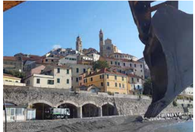
I lavori sul litorale
