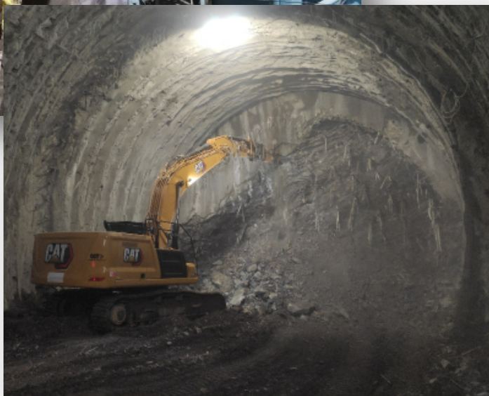
Consolidamento del fronte e scavo Galleria Pellizzarda
